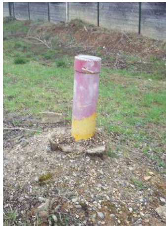
Photo 1 : Vue de l'ouvrage PZ1
